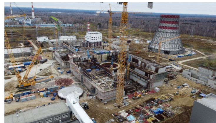
Вид на площадку строительства БРЕСТ-300 (2024 г.)
