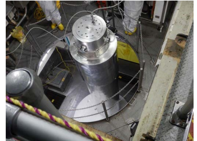
Вверху: Техники АЭС Норт Анна компании-оператора Dominion готовят транспортный контейнер, содержащий топливные стержни из топливных сборок с глубоким проектным выгоранием (НВУ), к отгрузке в адрес ОРНЛ. http://eprijournal.com/spent-nuclear-fuel-storage-demo-heats-up/
