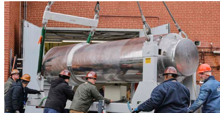
Вверху: Техники АЭС Норт Анна компании-оператора Dominion готовят транспортный контейнер, содержащий топливные стержни из топливных сборок с глубоким проектным выгоранием (НВУ), к отгрузке в адрес ОРНЛ. http://eprijournal.com/spent-nuclear-fuel-storage-demo-heats-up/
