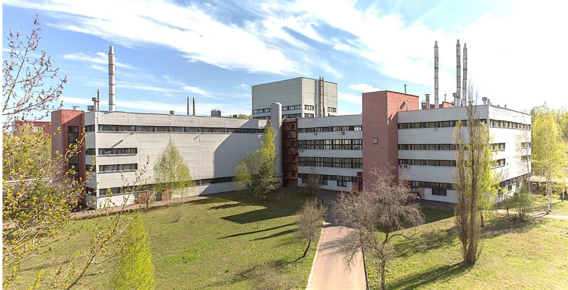
Внешний вид здания установки ИСКРА-5
