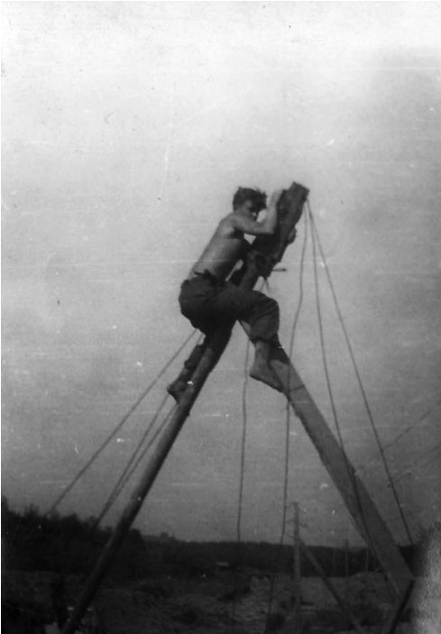
Студенческая межколхозная стройка ГЭС
