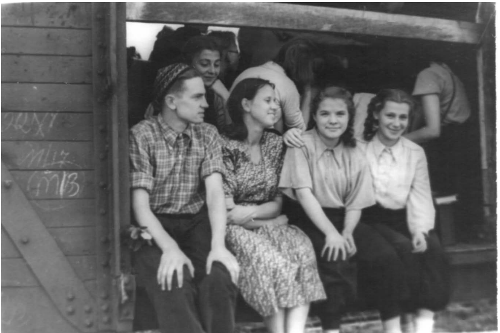
Студенческая межколхозная стройка ГЭС
