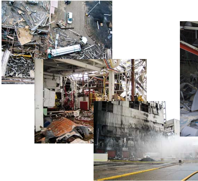
Последствия взрыва стандартного трейлера с водородом Muskingum River Power Plant's Unit 5 (США) 08.01.2007
