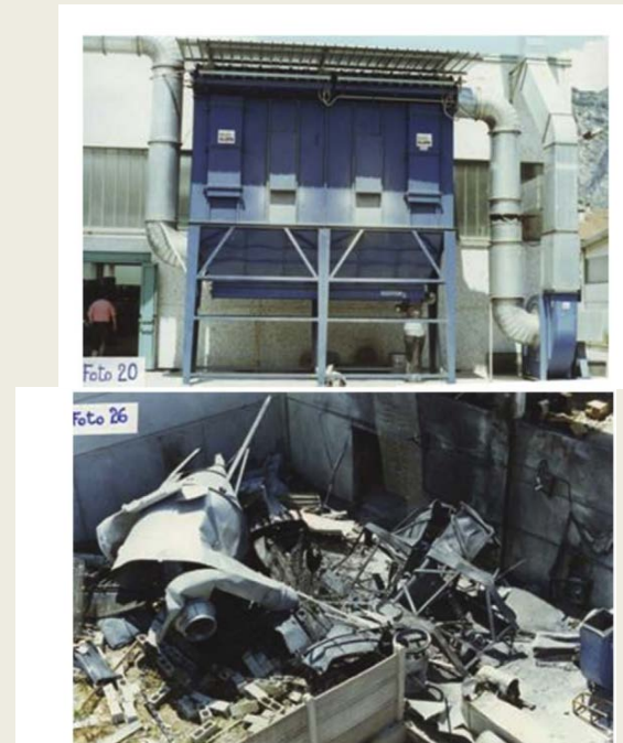
Фильтр до и после взрыва алюминиевой пыли
