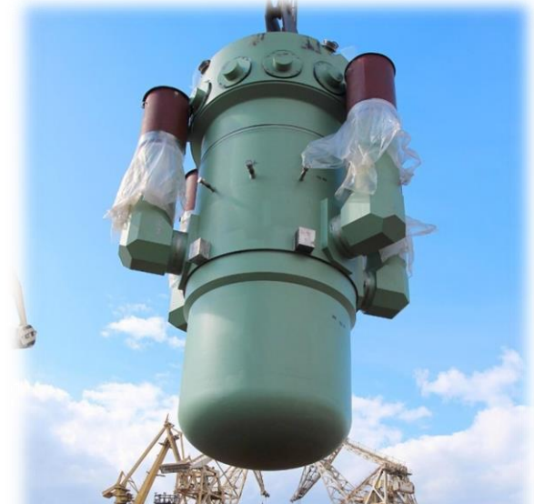
Монтаж ПГБ РУ РИТМ-200
